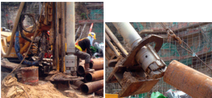
Фото OBS в работе:
